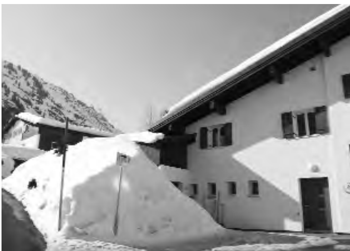
Spürbare Erhöhung der Wohnqualität durch Wärmedämmung und Aussensanierung, JHL, Stand letzte Saisonwoche, 20. 4. 2012
